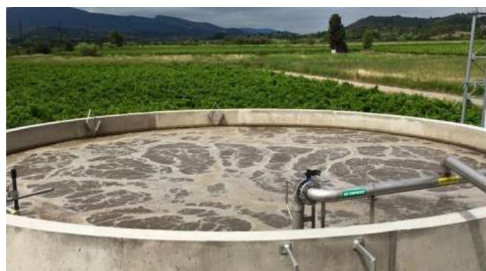
Image 15 : Station d'épuration de Conilhac-Corbières ; SOLIHA méditerranée, 2023
