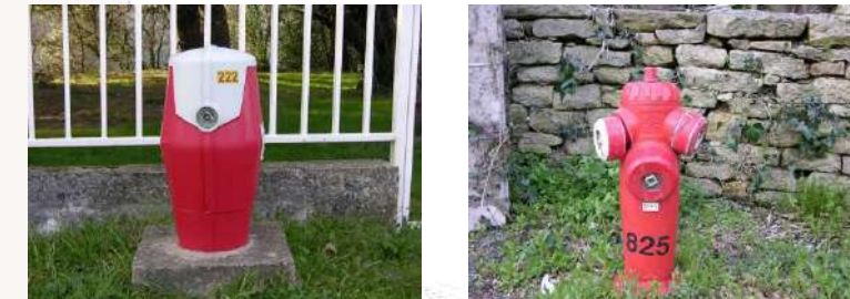
Exemples de numérotation de poteaux incendie
