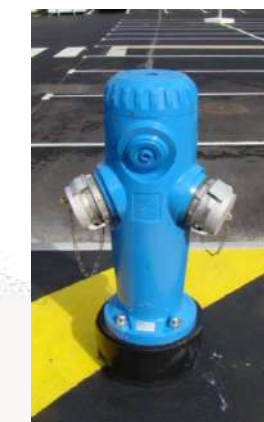
Poteau d'aspiration à réseau sec de 150 mm, muni de deux sorties de 100 mm et d'un Airclip. Pas de carré ni de volant de manœuvre
