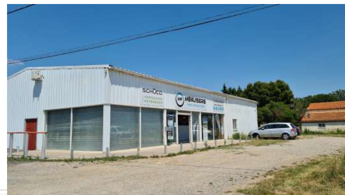
Image 17 : cabinet d'infirmières ; SOLIHA méditerranée, 2023
