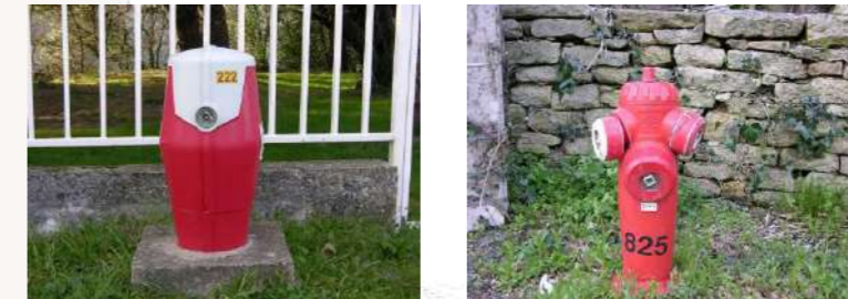
Exemples de numérotation de poteaux incendie
