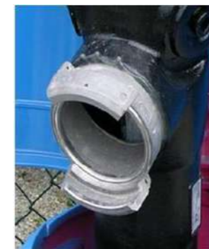
Poteau d'aspiration de 100 mm, muni d'une sortie de 100 mm,
