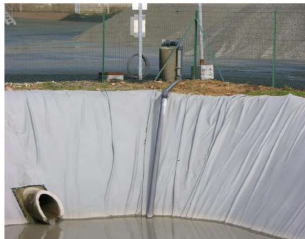
Réserve d'eau ouverte avec film PVC et une colonne d'aspiration de 100 mm
