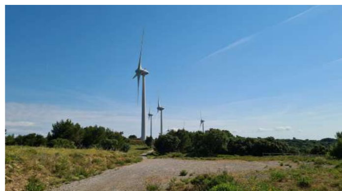
Image 16 : Parc éolien de Conilhac-Corbières, SOLIHA méditerranée, 2023
