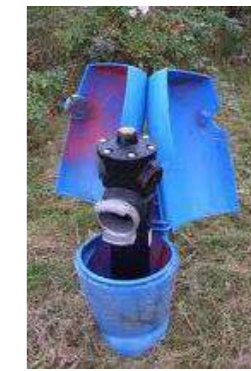
Poteaux d'aspiration de 100 mm à réseau sec, munis d'une seule sortie de 100 mm. Pas de volant ni de carré de manœuvre.
